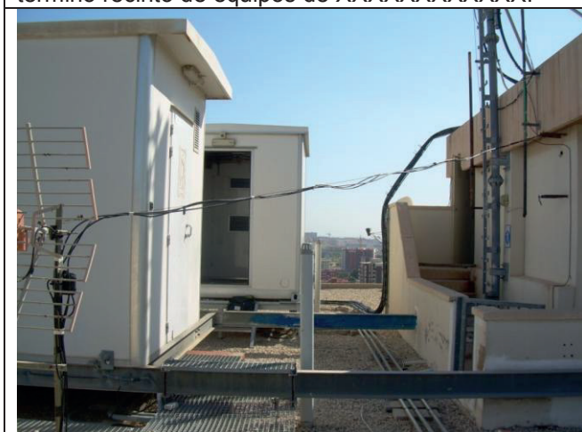
Foto 3. Vista de los recintos de equipos, con sus respectivas bancadas (a la izquierda XXXXXXXXXXXX y detrás XXXXXXXXXXXX). A la derecha se observa el casetón y el mástil de XXXXXXXXX.
